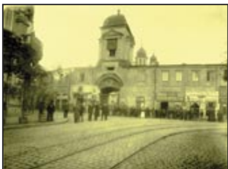
Hanul Zlătari, înainte de demolare.
