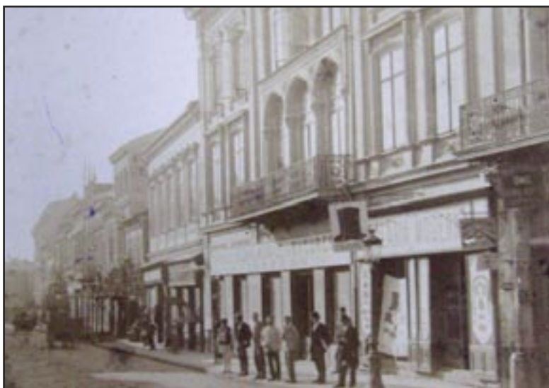
Strada Carol, actuala stradă Franceză.
